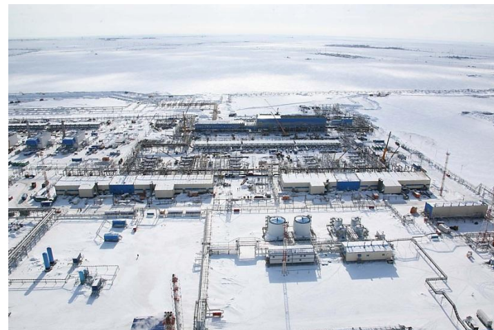
Ввод в эксплуатацию УКПГ (2 модуль) ГП-2
