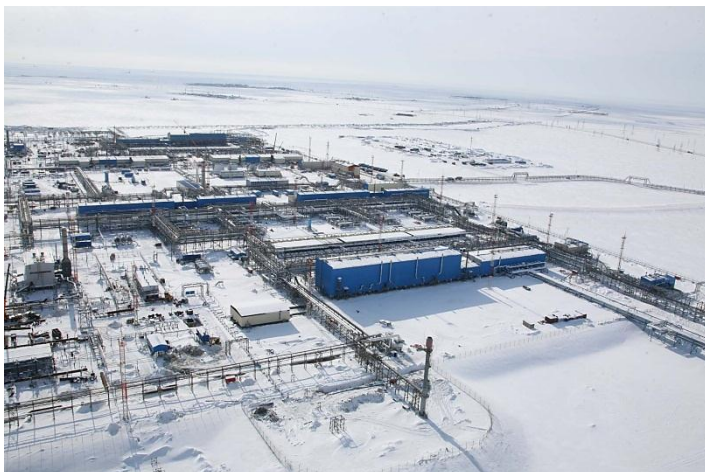
Ввод в эксплуатацию УКПГ (1 модуль) ГП-2
